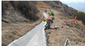
Drainage construction Construcción del sistema de drenaje
