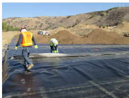
Cap installation Instalación cap
