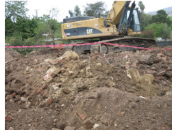
Debris removal Remoción de escombros
