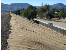
Erosion control Control de la erosión
